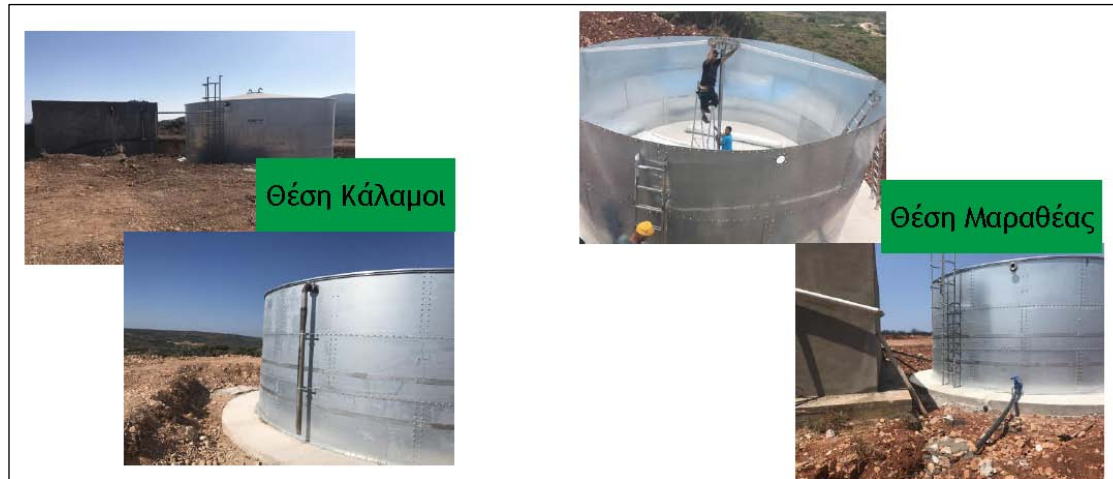
Εγκατάσταση δεξαμενών συλλογής ομβρίων υδάτων στο νησί των Κυθήρων (Non-Conventional Water Resources (NCWR) Programme, 2017).
